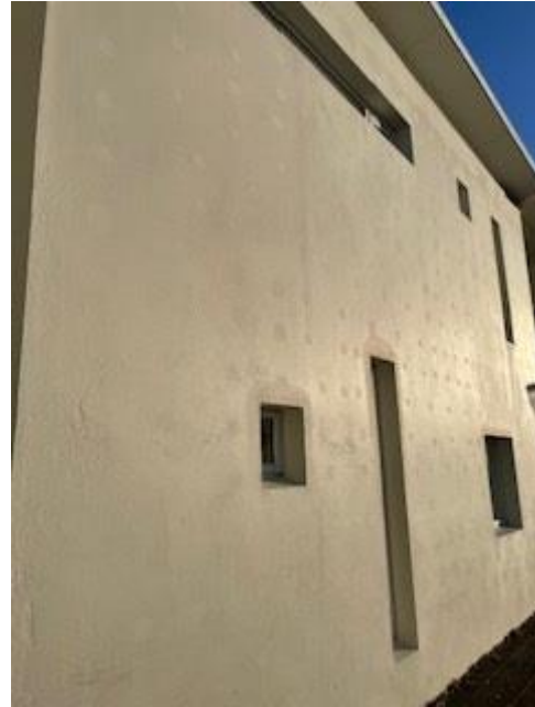
Mynd 2 Sjá má festingar fyrir einangrun þegar rakapétting á sér stað á útvegg
