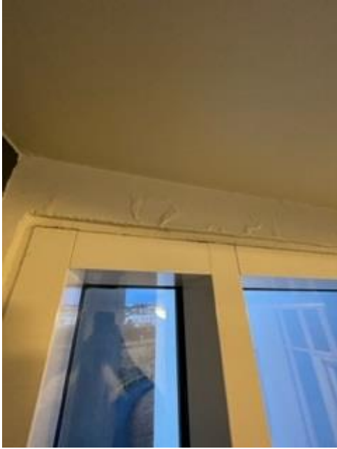
Mynd 9 Rakaskemmd á útvegg, sérkennslustofa 202, vestur 2. Hæð
