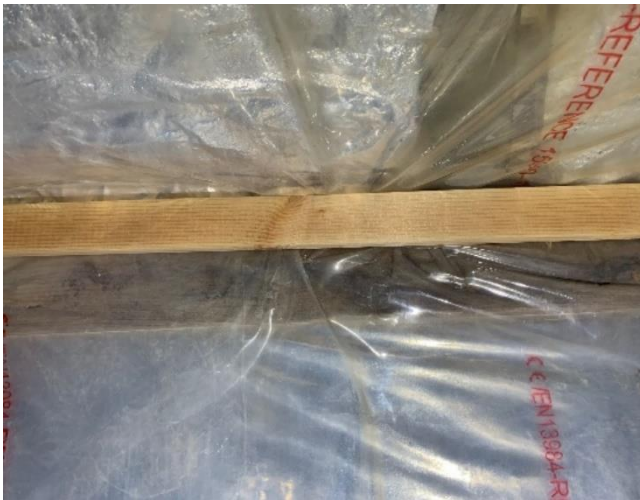
Mynd 10 Mygla í bita bakvið rakaserru ?
