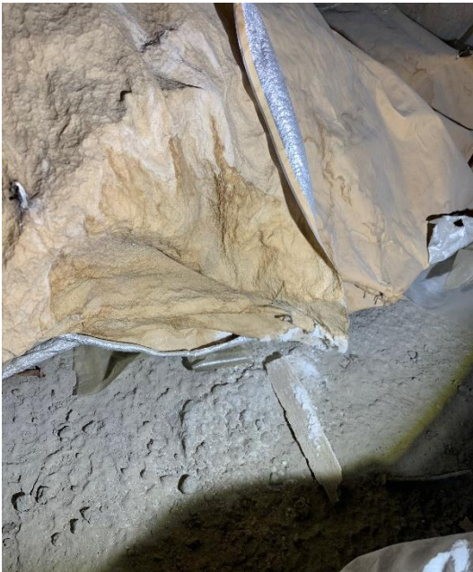
Mynd 4 Áfilma/pappír af glerull dottin niður.
