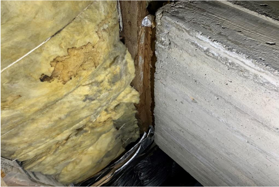
Mynd 37 Enginn raksperra og leki.
