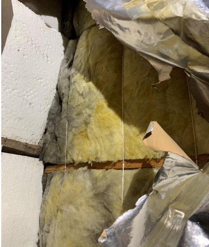
Mynd 33 Vindpappi dottin af glerull.
