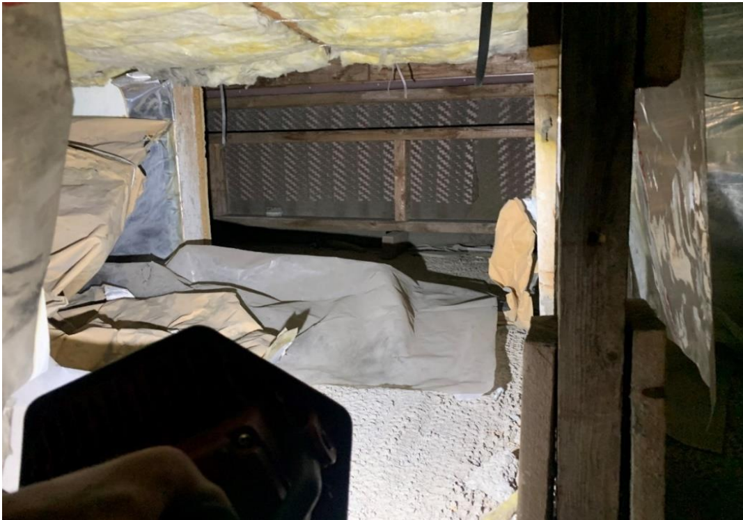
Mynd 30 Engin raka sperra á stafni og þaki.
