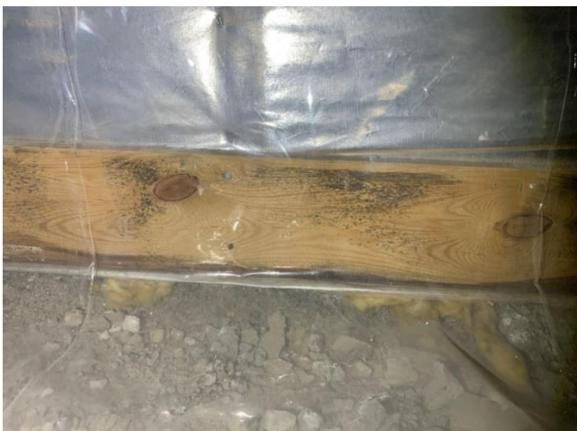
Mynd 11 Greinileg mygla í bita bakvið rakaserru.
