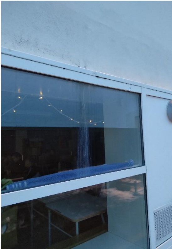
Mynd 16: Tæring efst í glugga vegna leka
