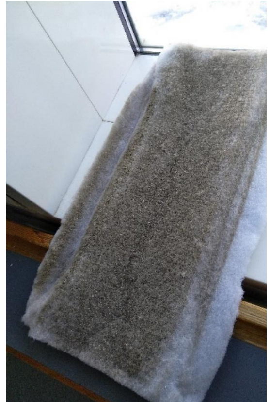
Mynd 39: Mikil óhreinindi í síu inntaksristar
