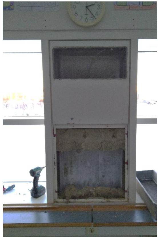
Mynd 32: Inntaksrist á milli glugga í stofu 108
