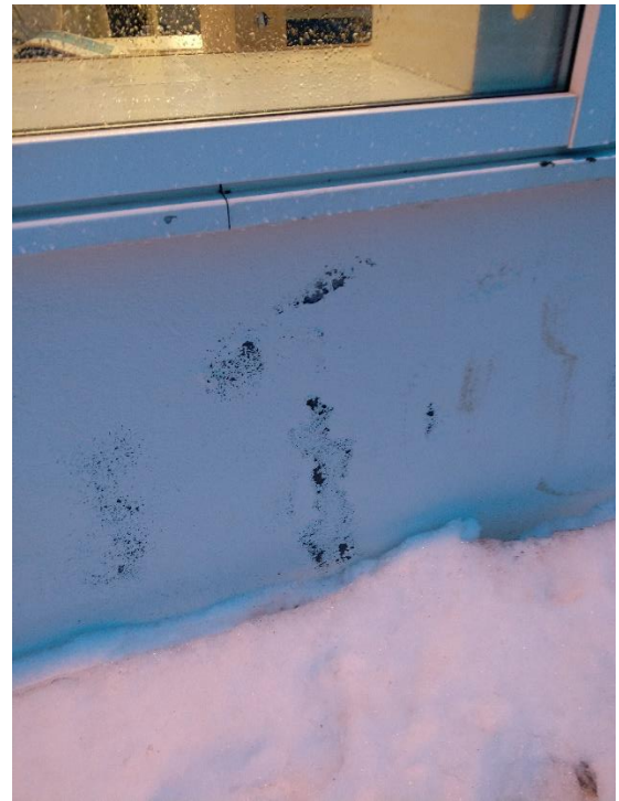
Mynd 15: Skemmdir á múrkerfi má finna víða
