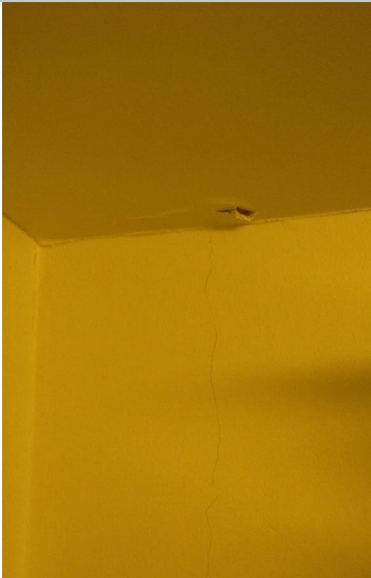
Mynd 30: Rakaskemmd í lofti sérkennslustofu 206
