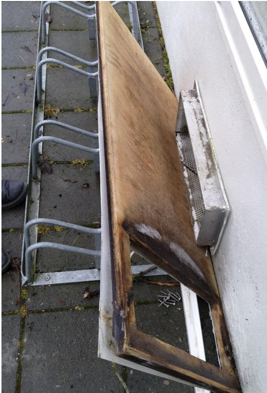
Mynd 40: Ytri timburplata við loftræstistokk milli glugga í stofu 208.
