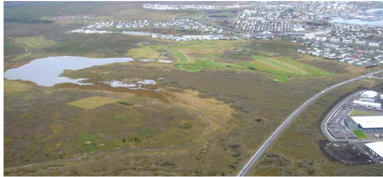
Mynd 2.3: Ljósmynd tekin til suðvesturs yfir Urriðaholt og Urriðavatn. Reykjanesbraut og Molduhraun sjást til hægri. Byggð í Hafnarfirði sést í fjarska.
