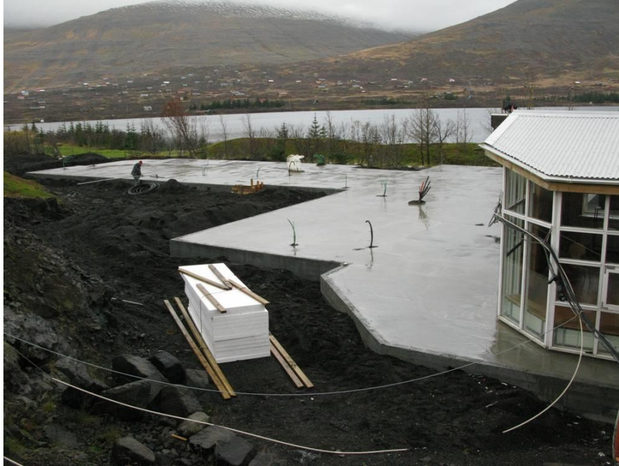
Gólfplatan steypð þann 17. okt. 2008
