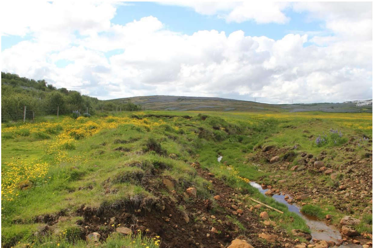
Mynd 2. Útfallsskurður frá Oddsmýri rétt ofan við ræsi undir Elliðavatnsveg. Horft í suður.
