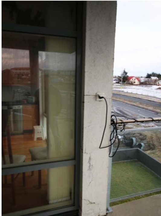
Mynd 2.1.1 Skemmdir eftir leka frá niðurföllum
