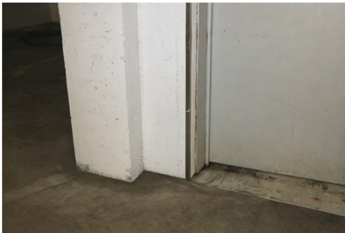
Mynd 3.2.1 Lekaummerki frá samskeyti milli þakplötu bílageymslu og aðalbyggingar
