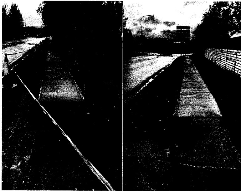
Búið að steypa í sömu breidd
