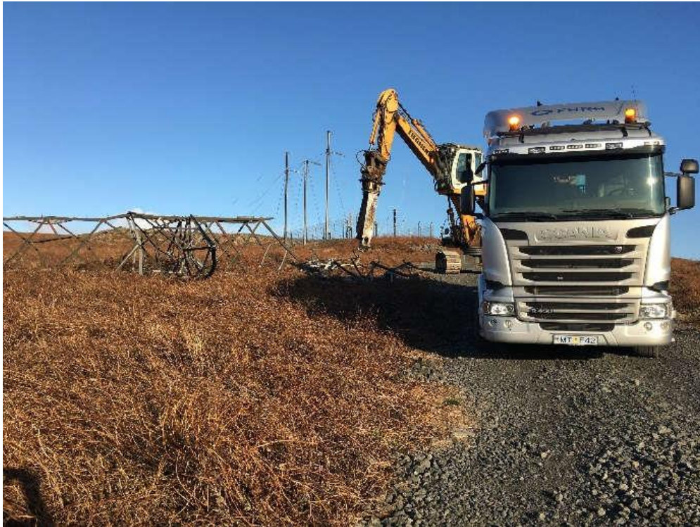
Mynd 3.3 Efni klippt niður og flutt með vörubíl af svæði.
