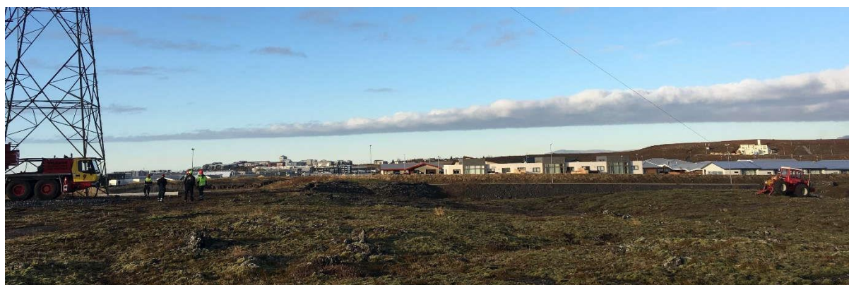
Mynd 3.2 Endamastur við Hamranes felld 2019. Traktor með spil togar í topp mastursins.
