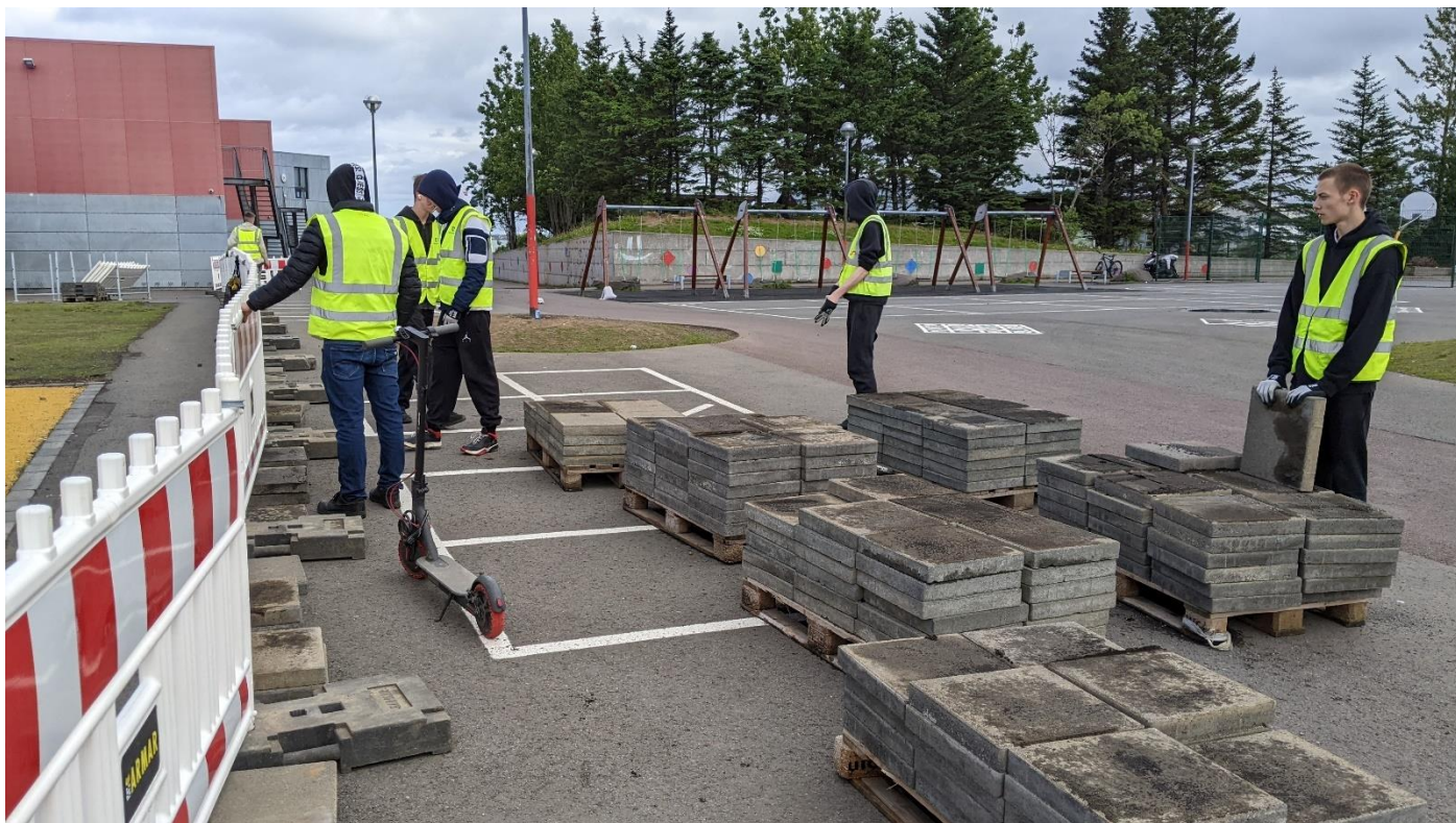
Mynd: Verið er að labba með hellur af brettum og raða undir grindverkið
