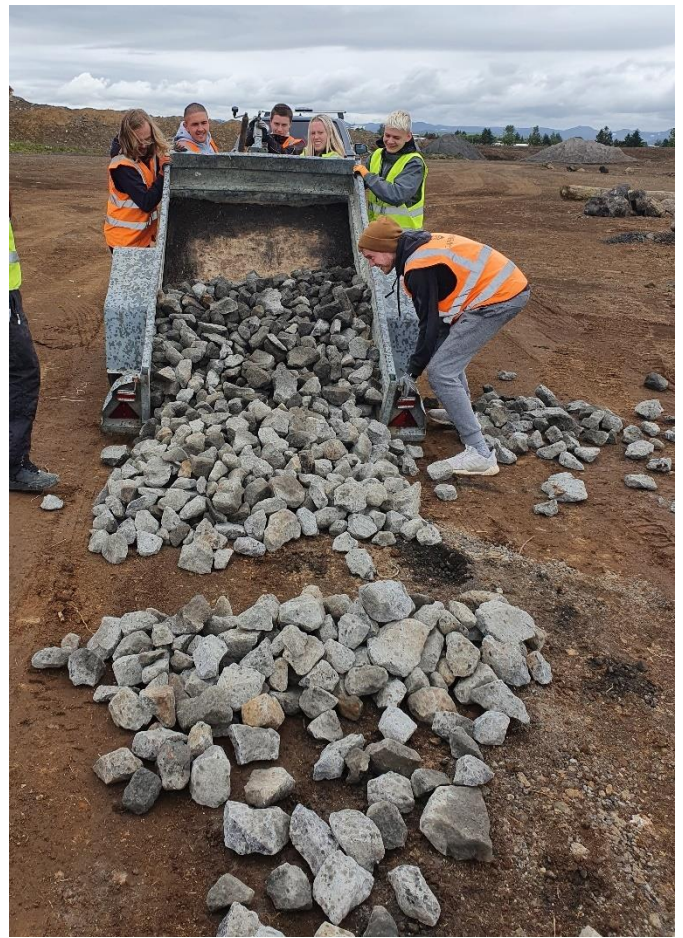
Mynd: Verið að losa grjótið á jarðvegstippinum
