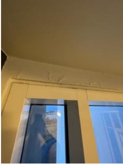
Mynd 9 Rakaskemmd á útvegg, sérkennslustofa 202, vestur 2. Hæð
