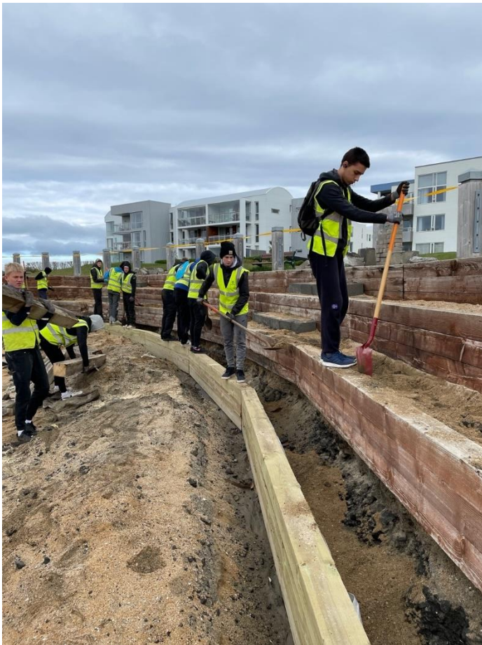
Mynd: Verið að byrja að moka úr þrepi 2 og fjarlægja gamla timbrið
