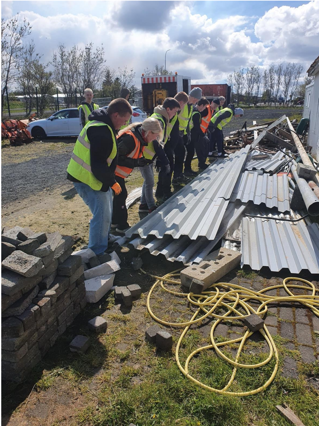
Mynd: Hópar 2 og 7 að hjálpast að við að lyfta bárujárnsplötum við gamla áhaldahúsið á Álftanesi
