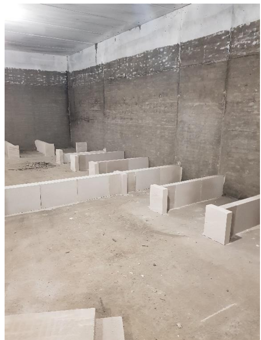
Verið að vinna í hlöðnum innveggjum í salerni á 2.hæð.
