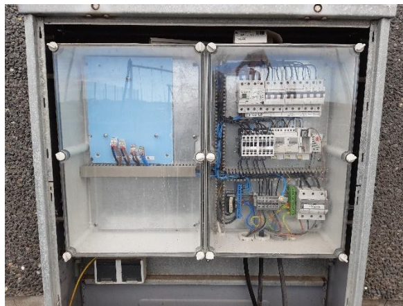
Mynd 2 Töflubúnaður í núverandi dreifitöflu fyrir vallarlýsingu.
