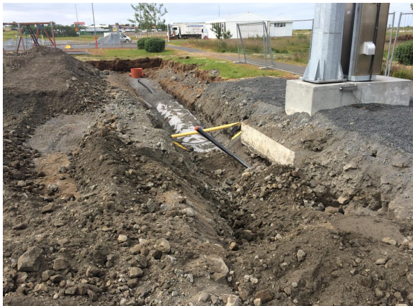
Mynd 6 Lagnavinna vegna gervigrasvallar 2015. Grafið 1-2m niður í lífræna lagið. Hluti af undirstöðum núverandi fjarskiptamastra sýnileg.
