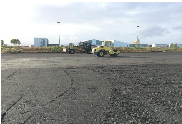
Mynd 8 Jarðvinna vegna gervigrasvallar á lokametrunum, útjöfnun og þjöppun
