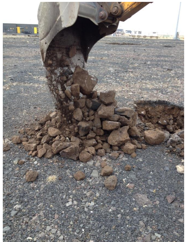
Mynd 4 Gróft fyllingarefni, sprengigrjót úr gryfju 4
