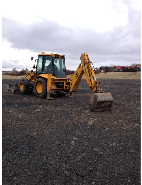
Mynd 2 Grafan sem notuð var til verksins, yfirborð malarvallar er veðrað og stráð hefur verið mól (2-5cm) yfir svæðið, nýtist sem „filter lag“
