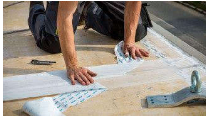
Mynd 6: Samskeyti á milli eininga þétt með heillímdum öndunardúk eftir reisingu
