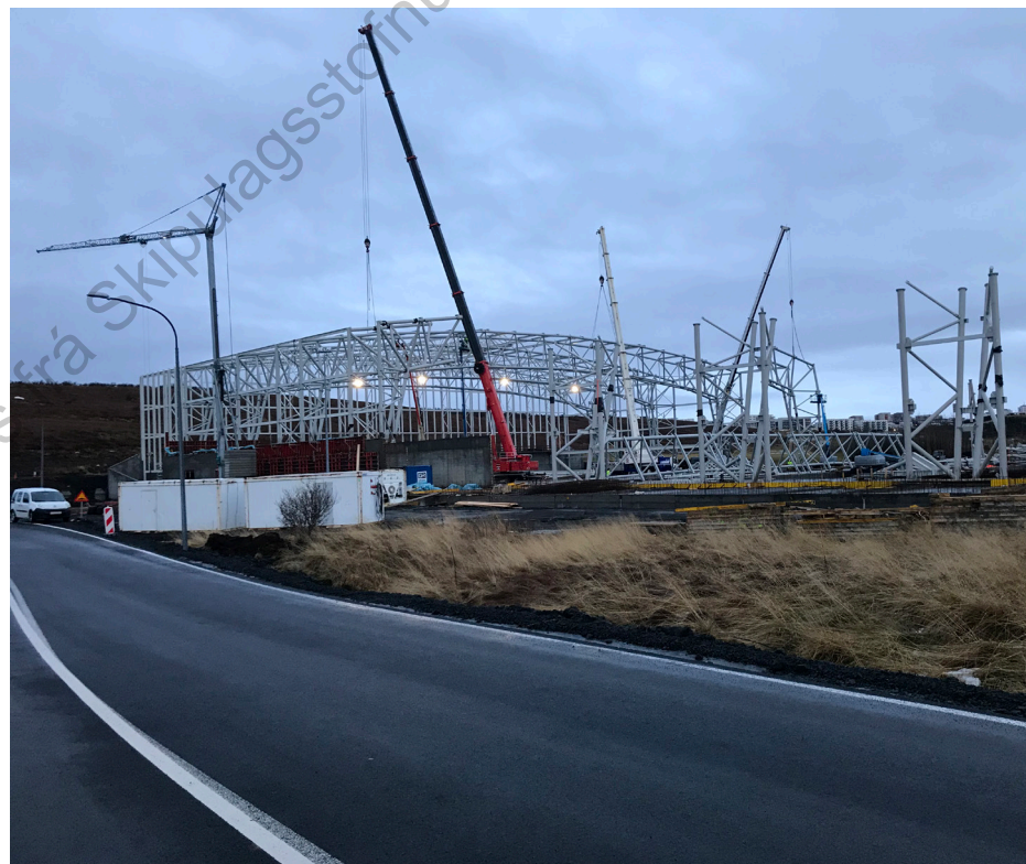
fjölnota íþróttahús í byggingu skv. eldra skipulagi
