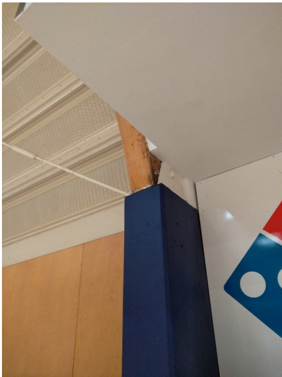
Mynd 3: Steyptar súlur/undirstöður fyrir sperrur
