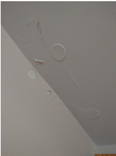
Mynd 3 Raka úrfellingar í vegg og lofti
