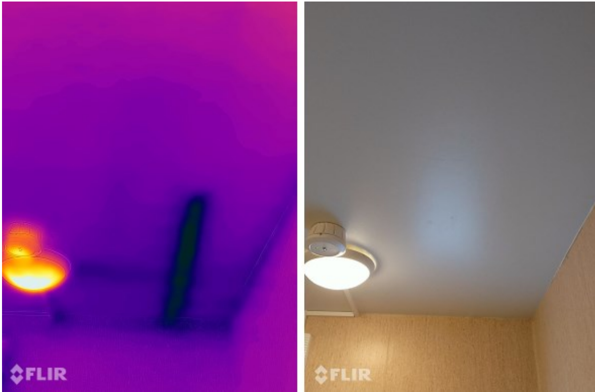
Mynd 24 Óútskýrðar kuldaslæður í lofti baðherbergis (gamall bílskúr)
