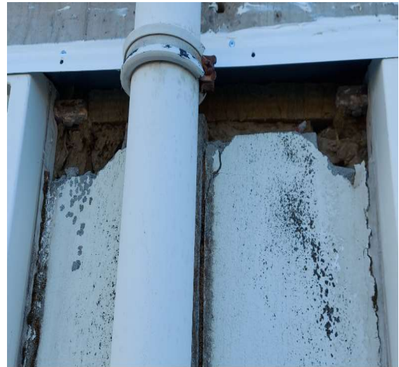
Mynd 2: Skemmdur frágangur milli glugga að utan.
