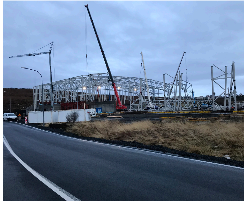
fjölnota íþróttahús í byggingu skv. eldra skipulagi
