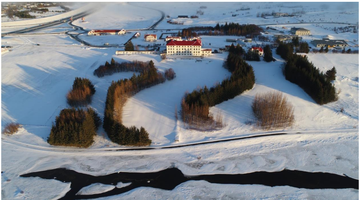
MYND 44 Flugmynd, horft til norðurs yfir Vífilsstaði, skróðgarð og Hraunsholtslæk. Vetrarmýri í fjarska.
