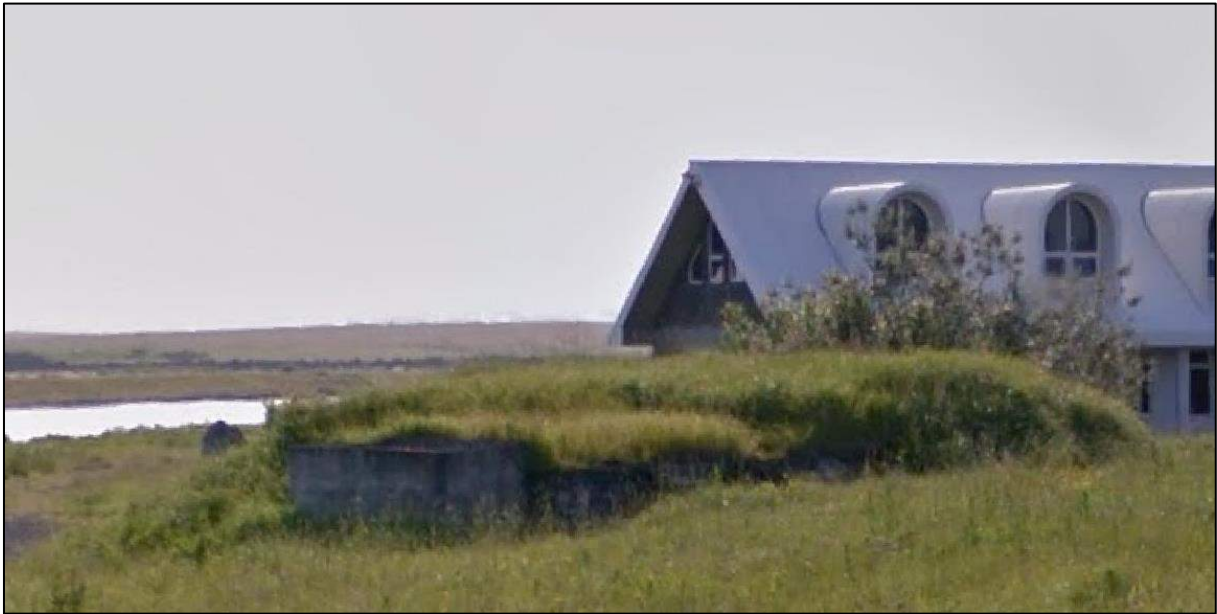
Mynd Niðurgrafin fjarskiptastöð [820] sem enn er ágætlega varðveitt að innan líka.
