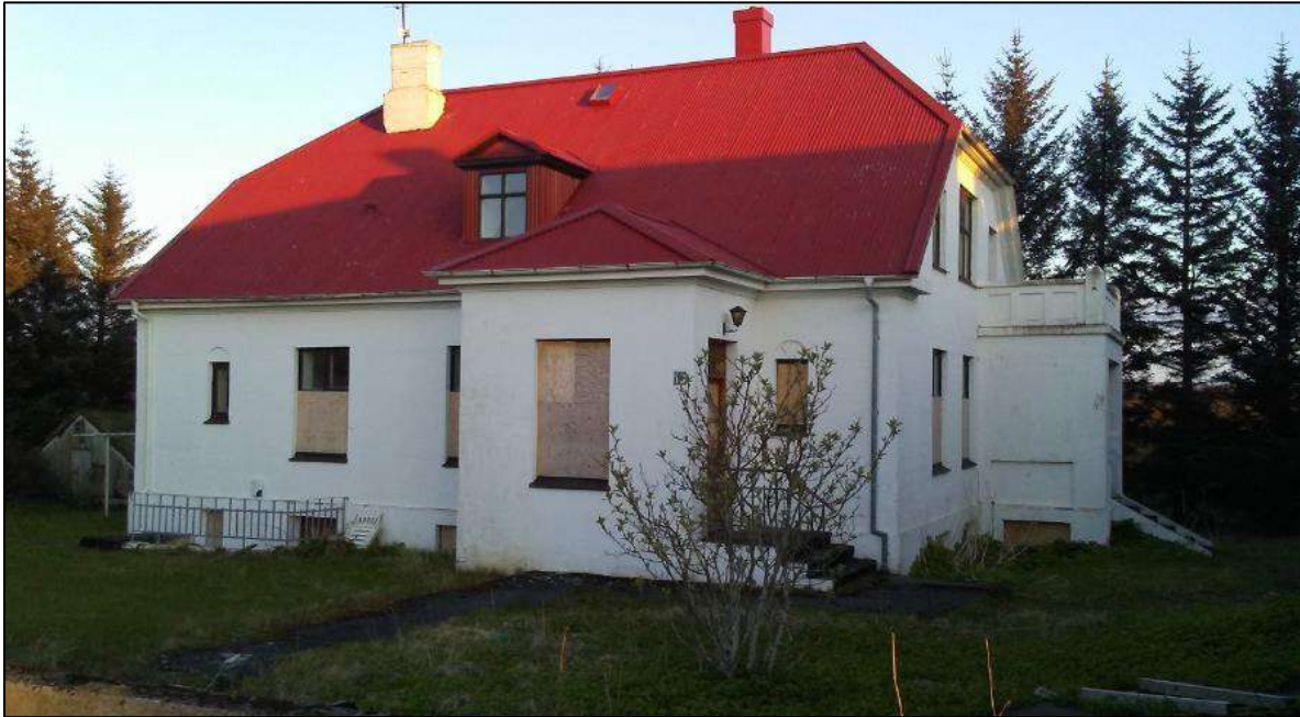
Mynd 13 Yfirlæknisbústaður [1603] á Vífilsstöðum byggður skömmu eftir 1910.
