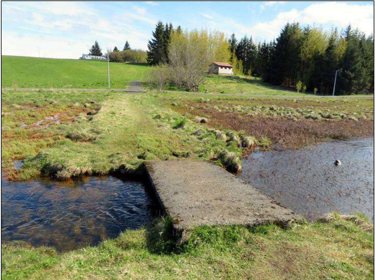
Mynd 19 Horft norður frá Vífilsstaðalækjarbrú [1610] og Suðurtröðum [1611] í átt að bæjarstæði Vífilsstaða [1600].
