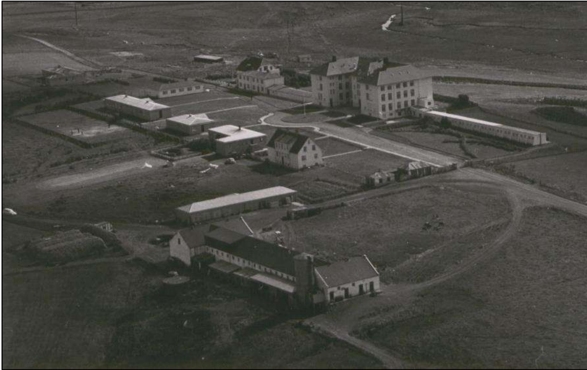
Mynd 17 Vífilsstaðaspítali og húsin í kring. Vegurinn liggur í gegnum hverfið en ekki fyrir norðan fjósið eins og í dag. Mynd fengin frá Garðabæ.
